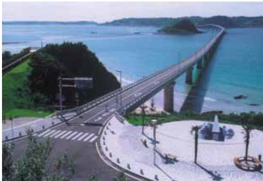
角島大橋（下関市）
