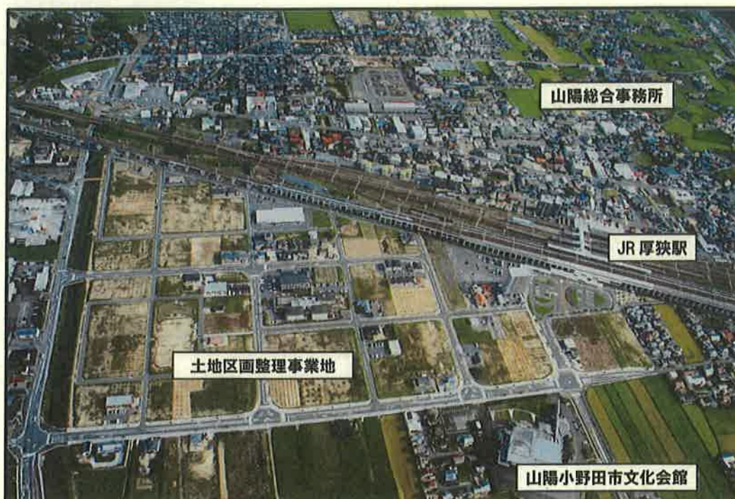
【厚狭駅周辺上空写真】
