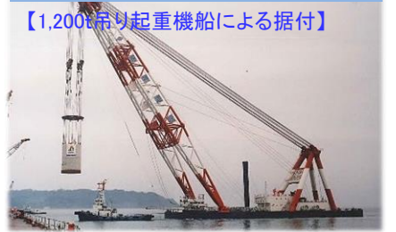
【1,300t吊り起重機船による架設】
