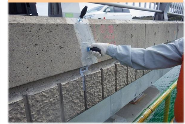
ひびわれ部からの塩分侵入を防ぐひびわれ補修工
