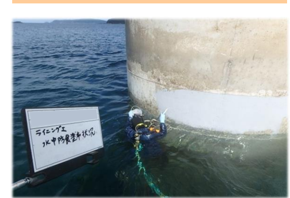
ひびわれ部からの塩分侵入を防ぐひびわれ補修工
