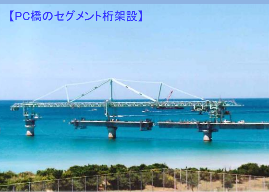
上部工施工(平成8年7月)
