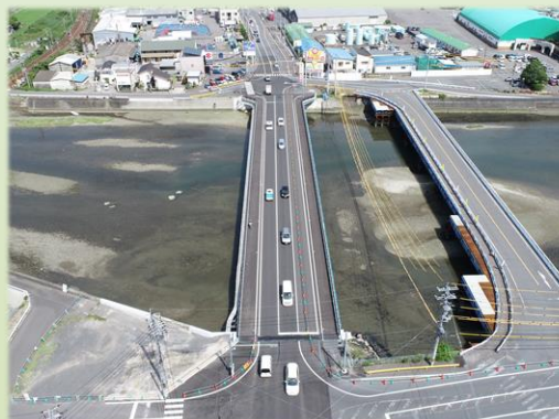
【橋梁の耐震補強】
