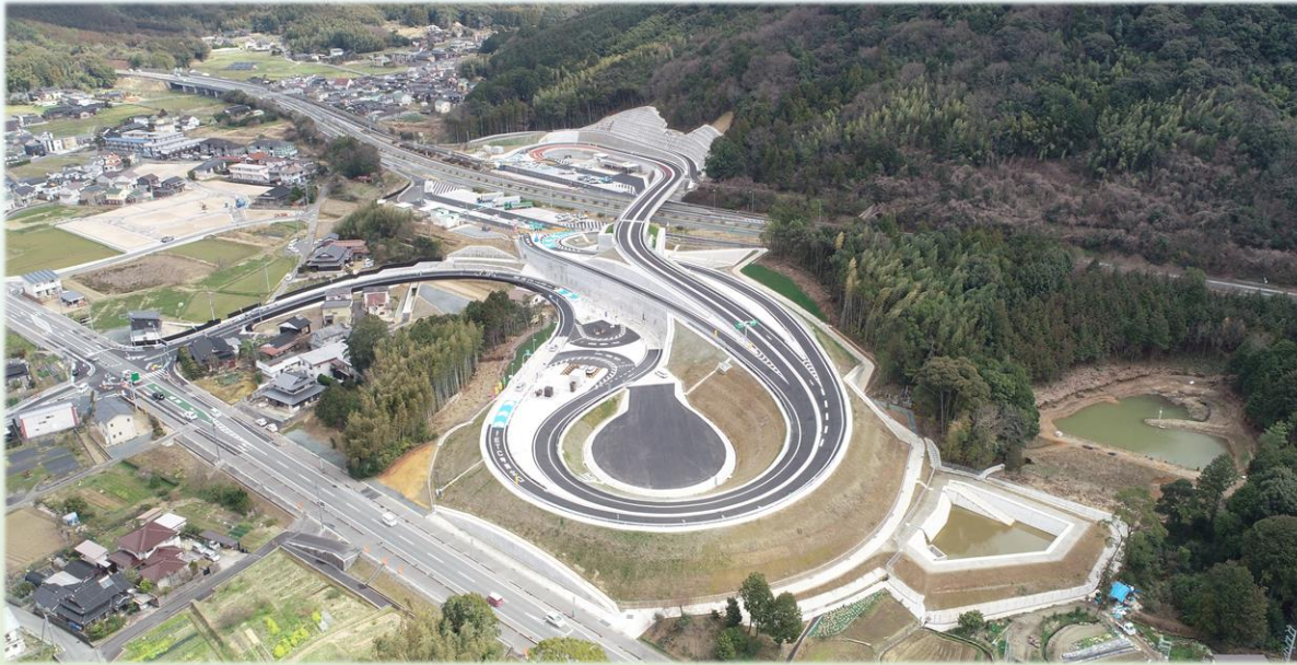
【スマートインターチェンジ】
