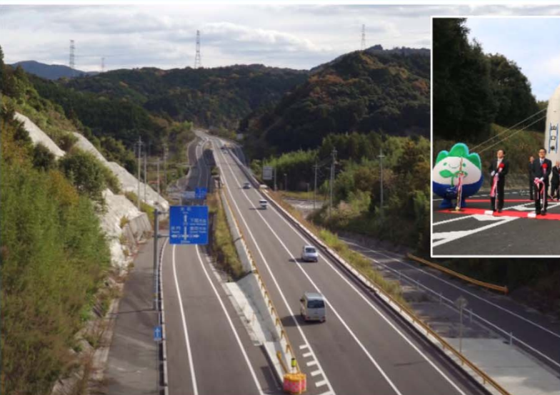
国道435号 美祢豊田バイパス 下関市 平成29年12月完成
