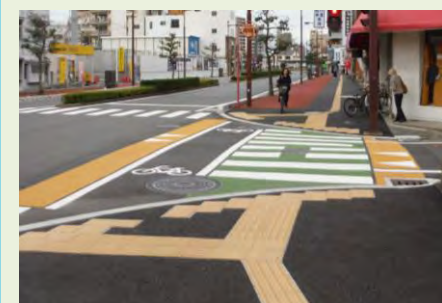
(主)岩国停車場線(岩国市)
