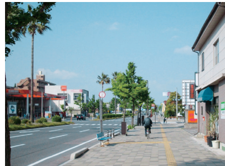
電線地中化後
