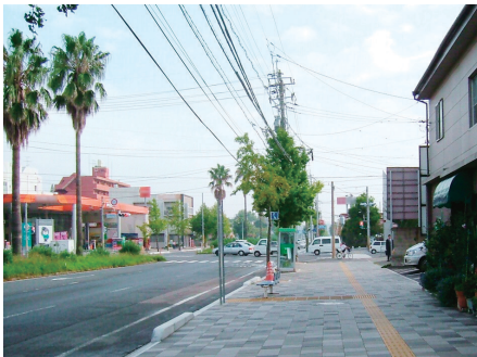
電線地中化前
