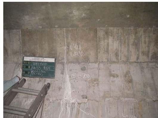
幅 0.1mm～0.2mm の方向性のあるひびわれ(東側側面～上面)
