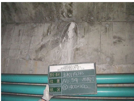
幅 0.1mm～0.2mm の方向性のあるひびわれ(西側側面～上面)
