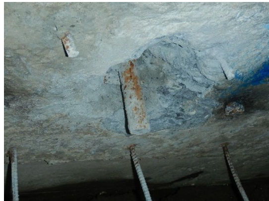
(上部工側の状況 : PC 鋼棒⑫)
