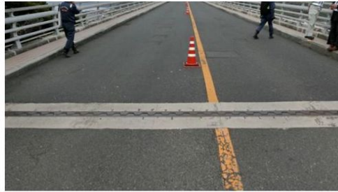
A1 橋台前面の PC ケーブル
