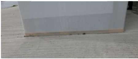
P2 橋脚付け根部
