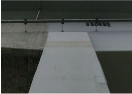
P2 橋脚柱頭部
