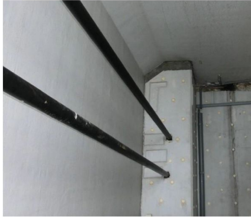
主桁と橋台を連結する PC ケーブルの橋台側定着部
