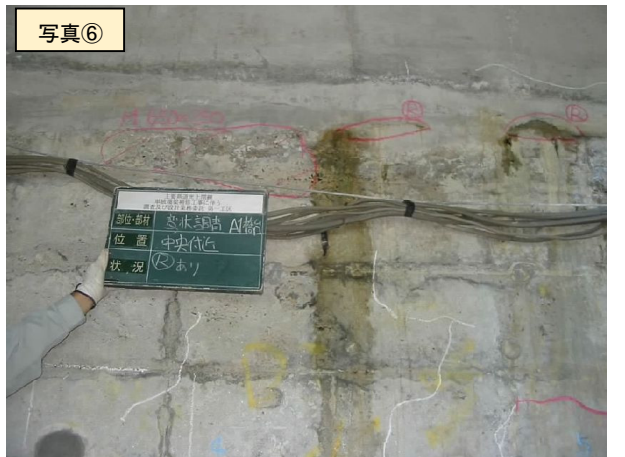
图 2.25 A1 橋台損傷写真
