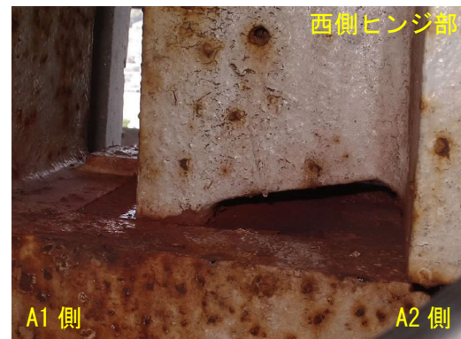
図 2.21 寸法計測位置図 (左) とゲレンク沓の状態写真 (右)
