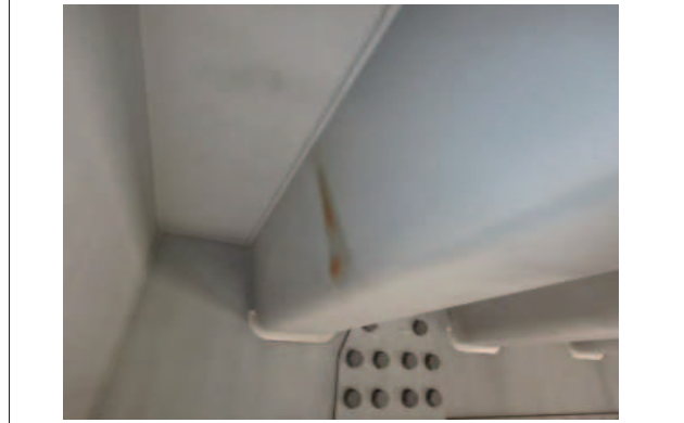
⑥ 部材 その他(落橋防止装置) 判定区分 II
