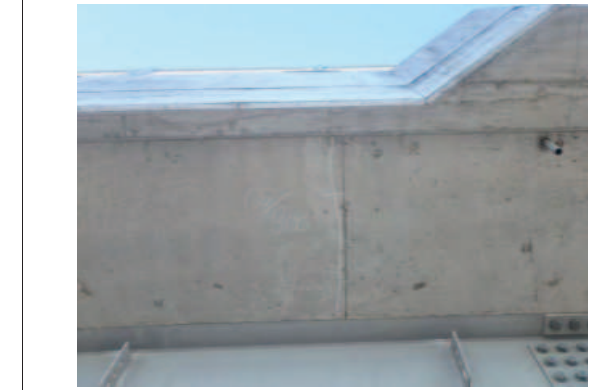
⑥ 部材 その他(落橋防止装置) 判定区分 II
