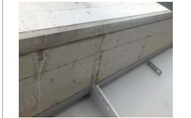
⑥ 部材 その他(落橋防止装置) 判定区分 I
