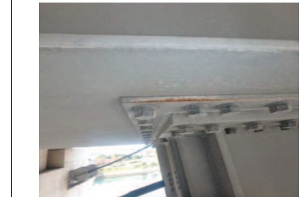
⑥ 部材 その他(落橋防止装置) 判定区分 II
