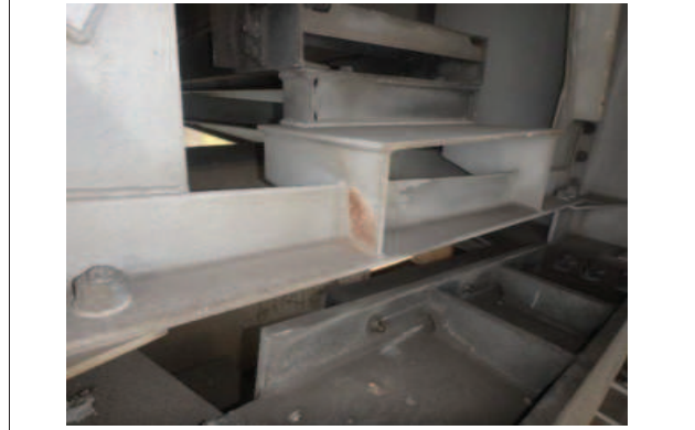
⑥ 部材 その他(落橋防止装置) 判定区分 I
