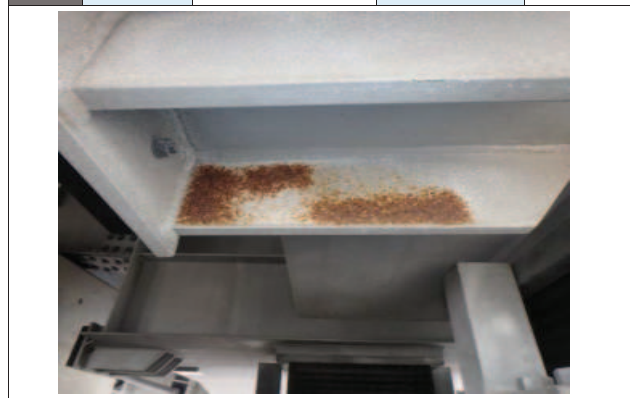
⑥ 部材 その他(落橋防止装置) 判定区分 II
