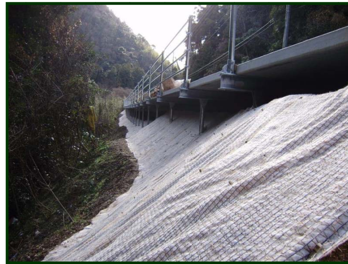
張りウッド・施工直後
