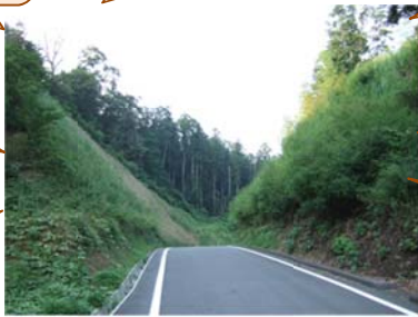
YE ソイル 2 号施工例：二鹿・川越線（施工後 3 年）
