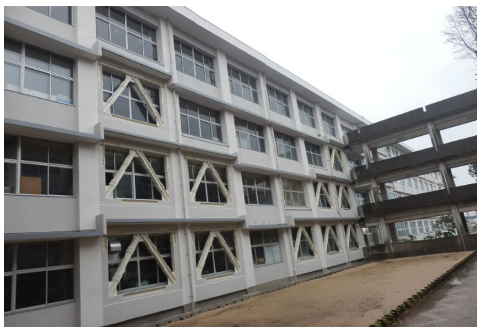
H26年度 下関工業高校普通教室棟耐震改修工事
