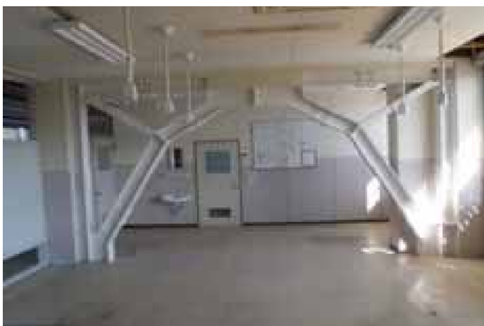
H21年度 育成学校本館耐震改修工事
