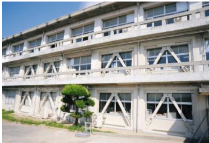
H22年度 光高校管理棟他耐震改修工事
