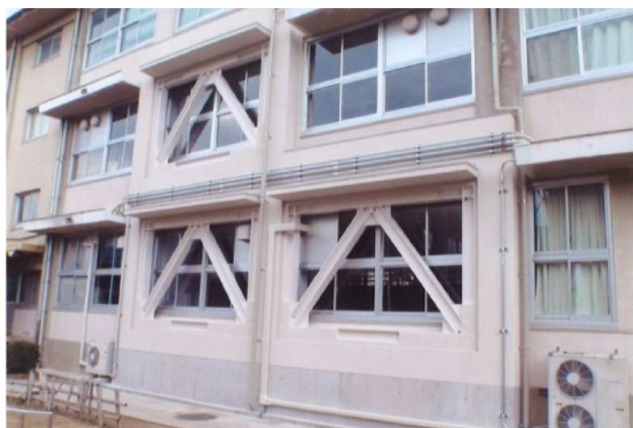
H23年度 光高校普通教室耐震改修工事
