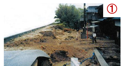
※山口地区(新地)護岸倒壊による浸水状況(H11.9.24)
