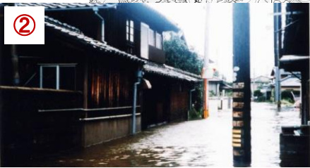
※防府地区浸水状況(H11.9.24)
