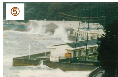
※笠戸島地区浸水状況(平成11年台風18号)
