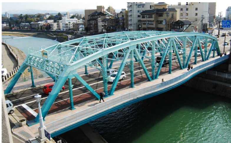
図 7-3-1 国道 157 号犀川大橋
