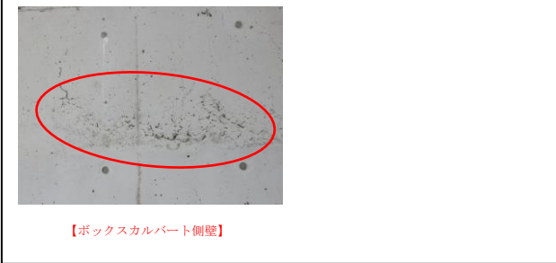
図-5.1 施工中に発生する不具合事例
