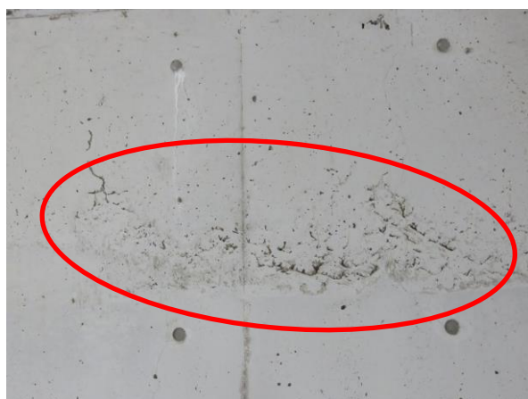
【ボックスカルバート側壁】
