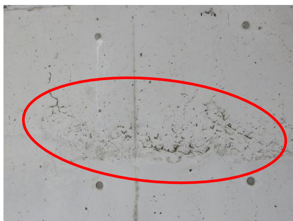
【ボックスカルバート側壁】
