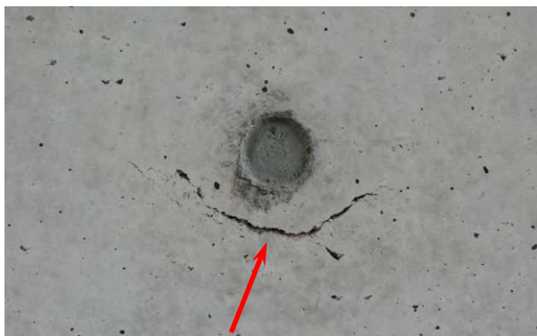
【セパレータコーン跡下方】
