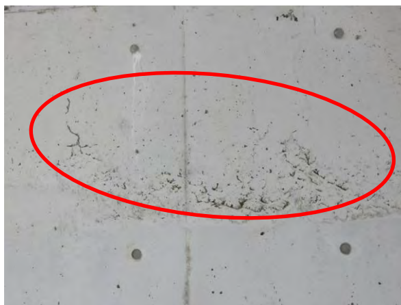
【ボックスカルバート側壁】
