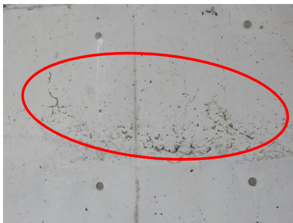
【ボックスカルバート側壁】
