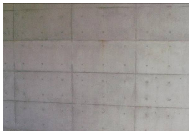
【不適切な打重ねが認められない構造物】
