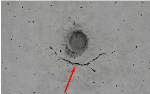
【セパレータコーン跡下方】
