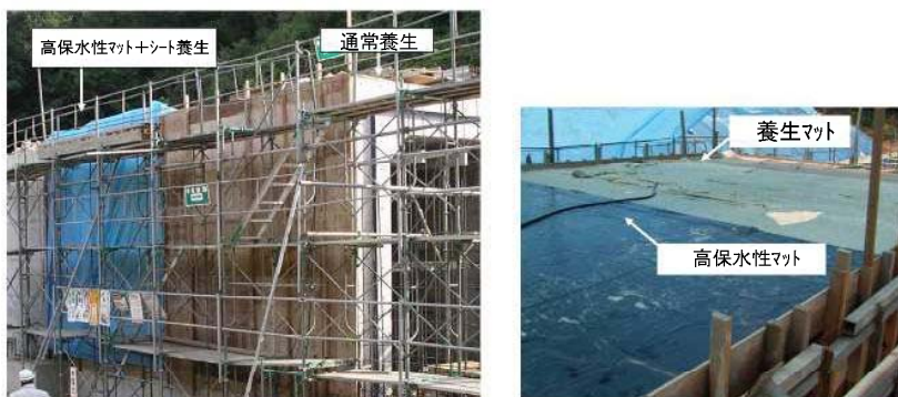
写真3. 3 ボックスカルバートの養生状況
