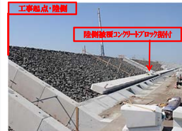
工事起点・陸側
