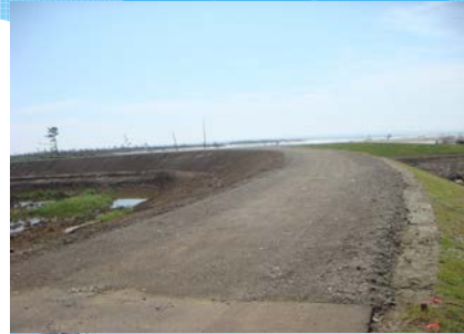
暫定復旧完了写真
