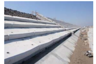
陸側被覆コンクリートブロック据付
