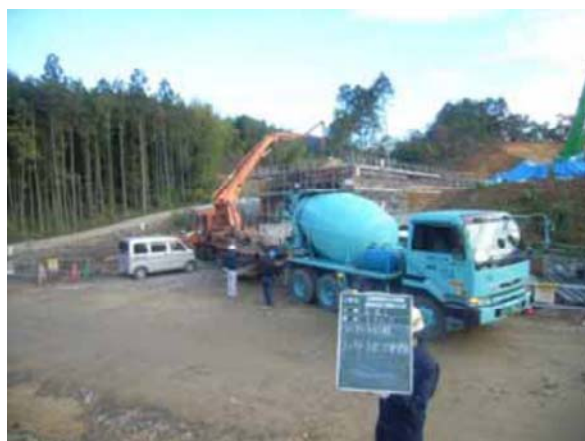
コンクリート打設状況
