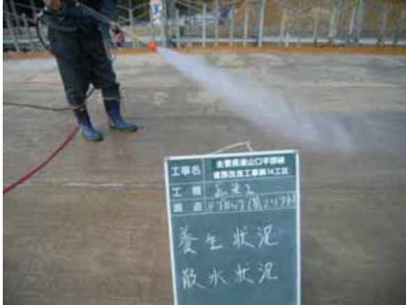
養生状況(散水状況)
