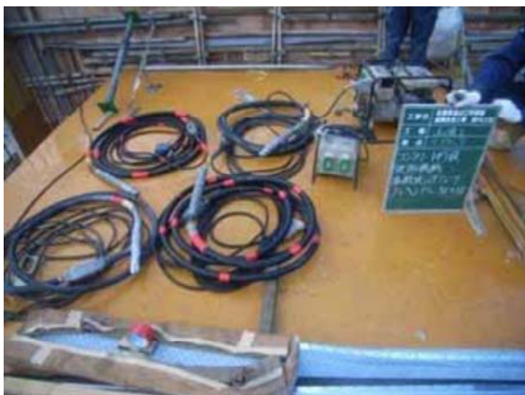
9ブロック施工時(使用機械)
