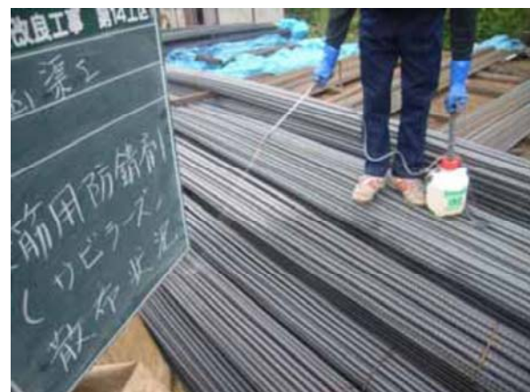
鉄筋用防錆剤散布状況
