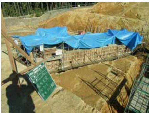
養生状況（ブルーシート設置）
