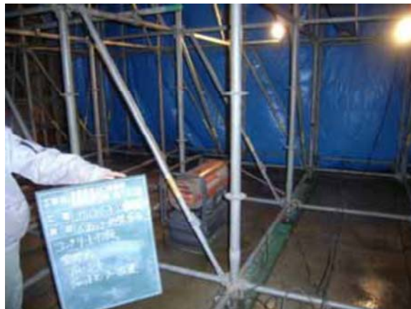
コンクリート打設(ブルーシート設置・ジェットヒーター設置)
