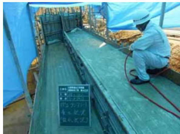
養生状況（養生マット敷設 散水状況）
