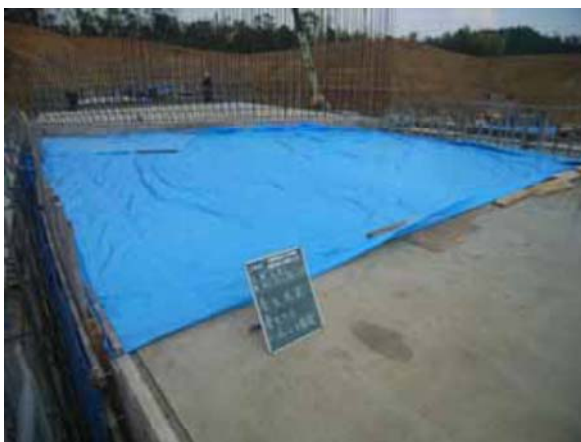
養生状況(ブルーシート敷設)
