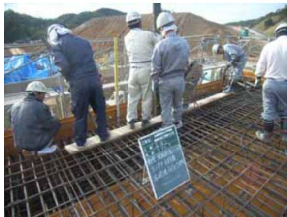
コンクリート打設状況(打設高さ測定)
