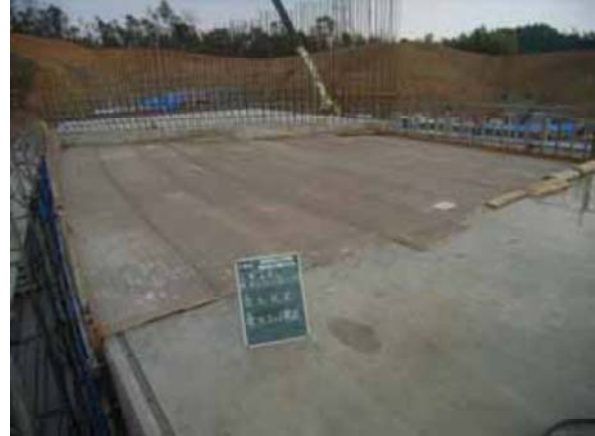
養生状況(養生マット敷設)
