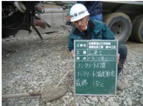
コンクリート温度測定(最終)
