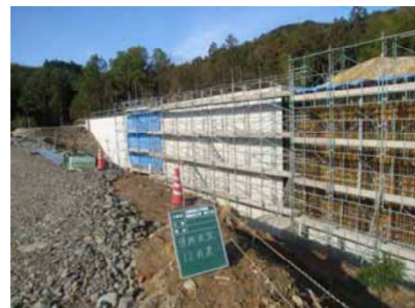
養生状況(ブルーシート設置)
