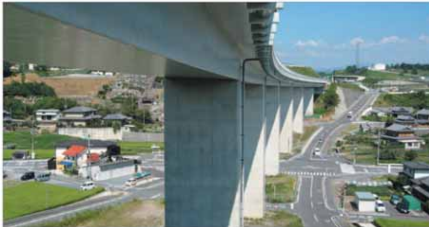
写真 垂井高架橋全景
