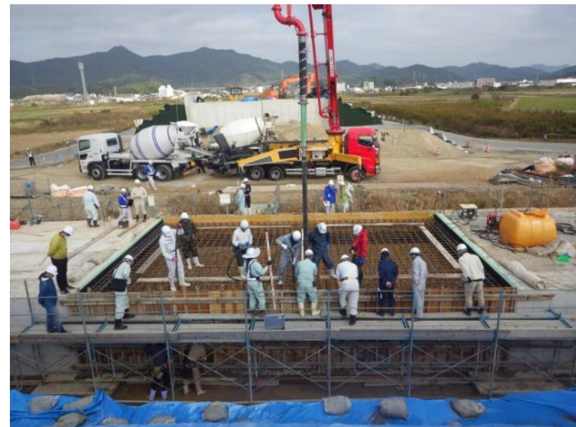
施工の確認状況
