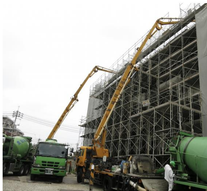
写真1 ポンプ車による打設
