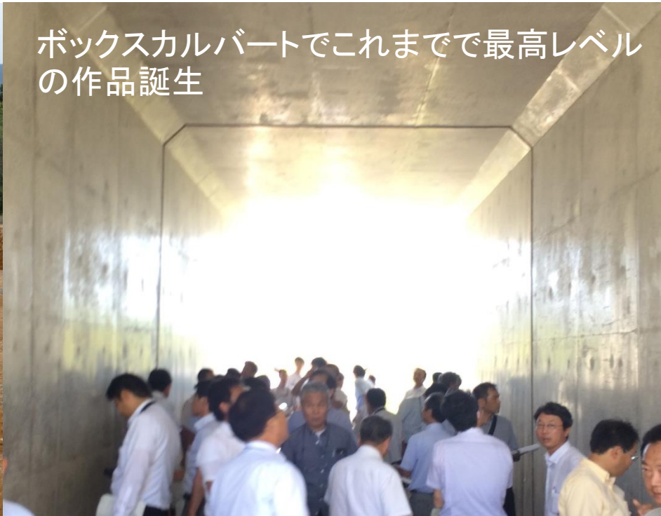
産官学協働による試験施工でひび割れ問題に活路を見いだした
