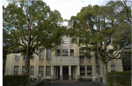
建設技術センターが入所している春日山庁舎 (旧県立図書館: 昭和3年築)
