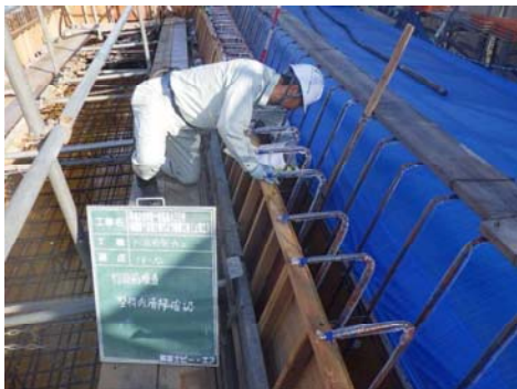
型枠内部の異物除去
