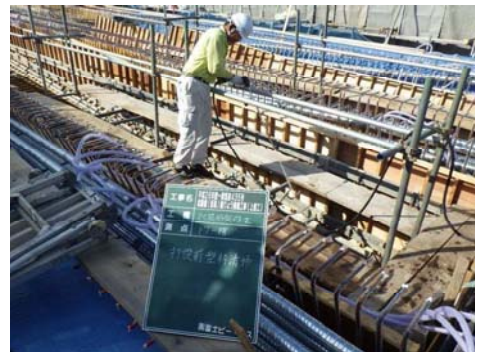
高圧洗浄機による型枠内清掃
