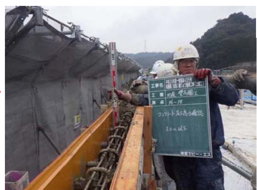
コンクリート打設高さ確認
