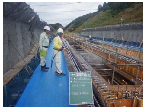
型枠面、打継面の散水
