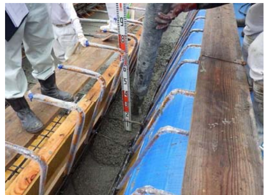
打設落下高さ
