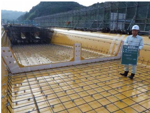
KKシート貼付
