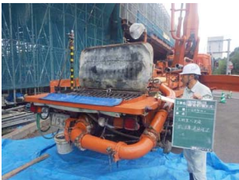
ポンプ車の清掃
