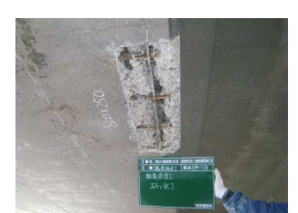
橋梁点検による損傷確認箇所
