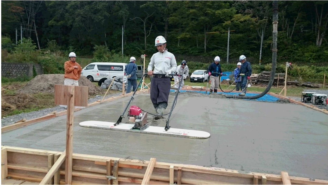
平坦性確保のための新工法の適用試験
