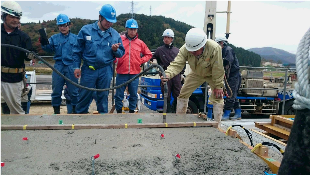
バイブレータによる振動締固め状況の確認
