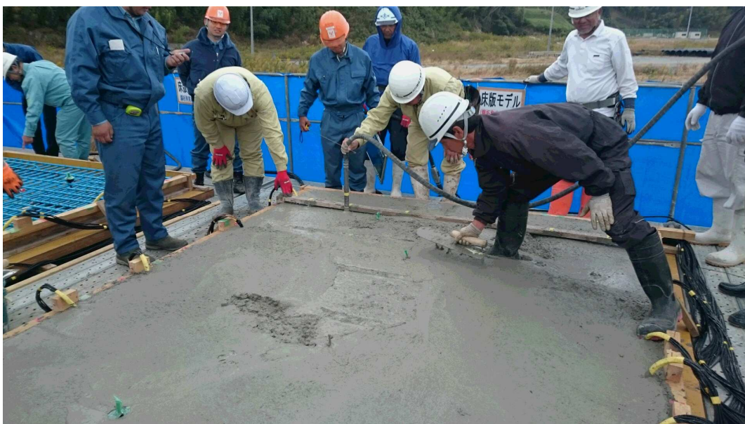
左官工によるコテ仕上げの施工性確認
