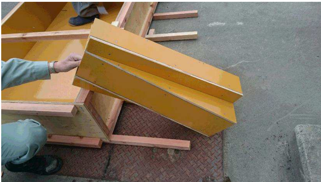
排水柵の下部を木製型枠で模して試験施工を実施
