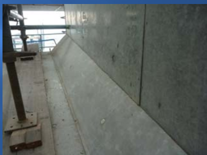
コンクリート打設後
