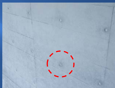
Pコン設置状況
