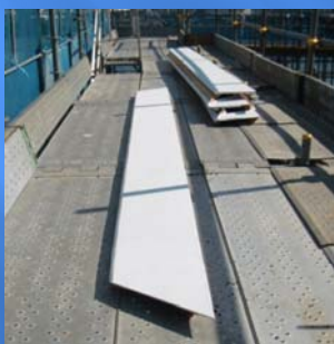
透水性シートの貼付
