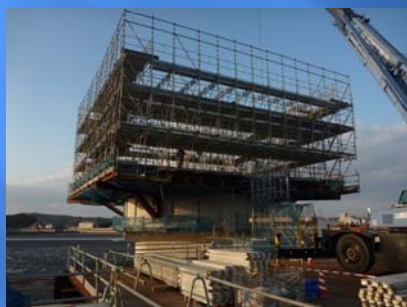
ブラケット支保工
