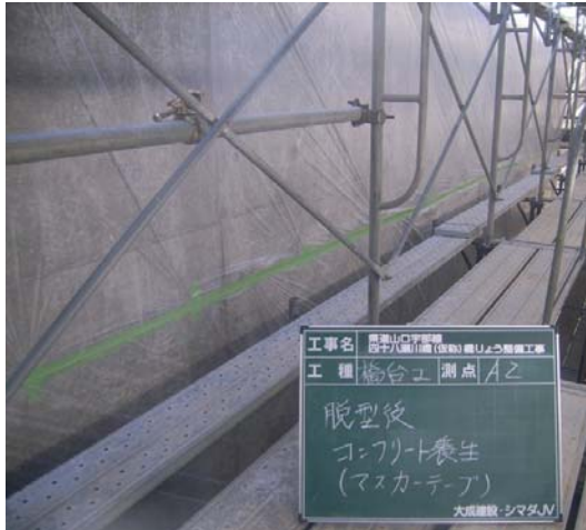
脱型後コンクリート養生(マーカーテープ)
