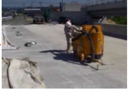
目地(カッター・縦目地)
