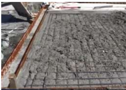
鉄網と縁部補強金設置
