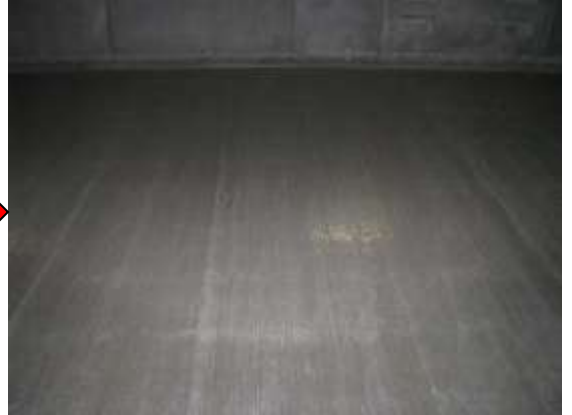
養生剤散布後のCo表面
