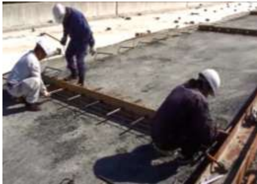
横目地の施工
