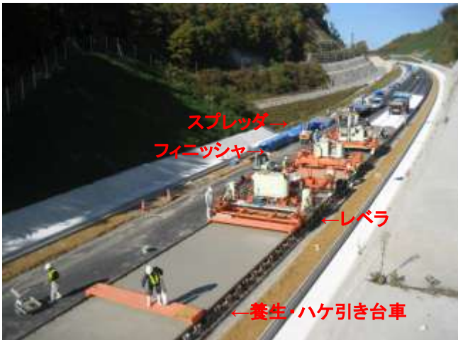
セットフォーム工法による施工全景
