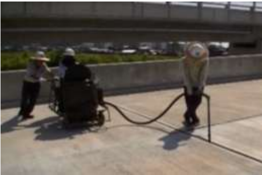
目地(注入・横目地)
