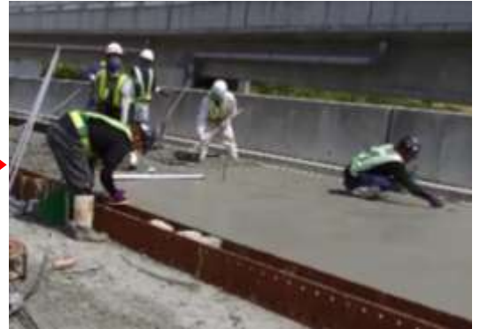
コンクリート打込み(上層)
