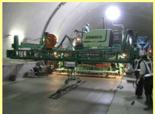
レベラ部(平たん仕上げ作業)
