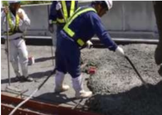
コンクリート打込み(下層)
