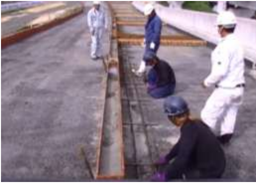
型枠設置と縦目地の施工
