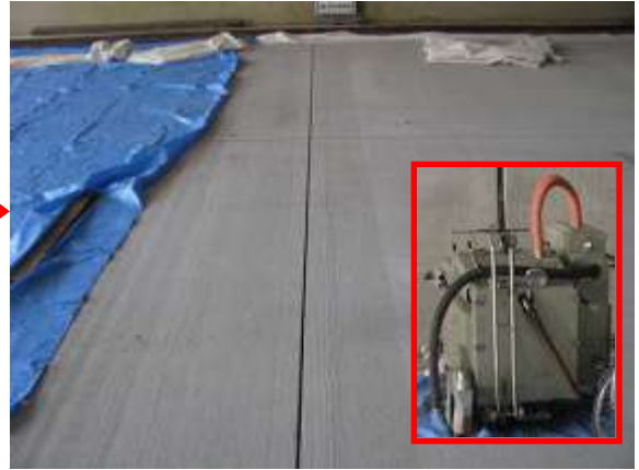
カッターによる目地切り
