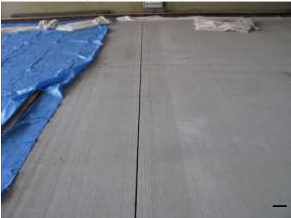
カッターによる目地切り
