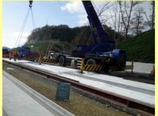
舗装機械据換え状況(セットフォーム)
