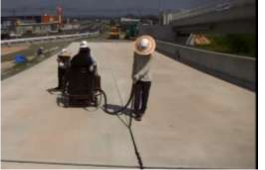
目地(注入・縦目地)
