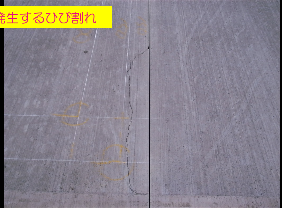
横目地端部に発生するひび割れ
