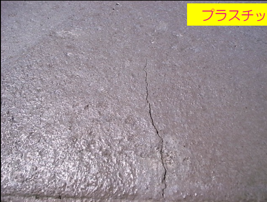
膨張目地の移動による破損
