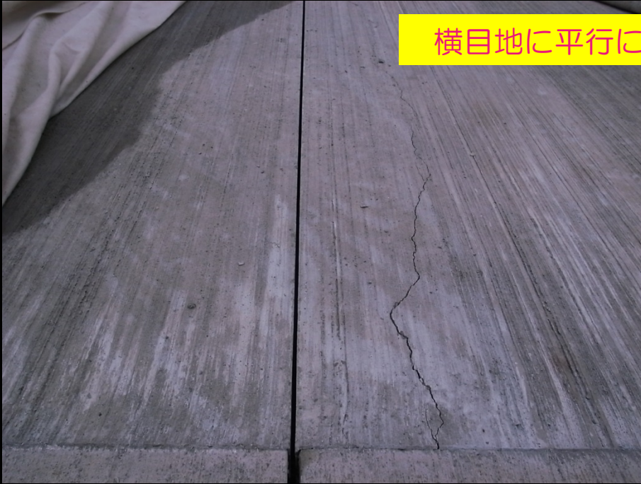
横目地端部に発生するひび割れ
