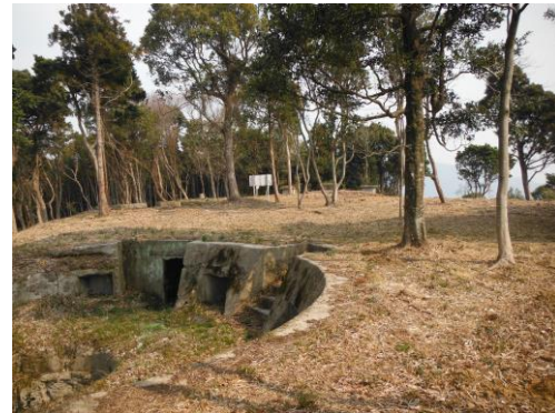
伐採・整理後の状況
