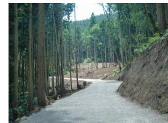
写真2 林業専用道「東イラオ山線」
