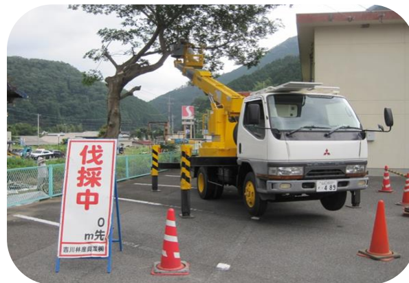
中国電力 電線伐採事業
