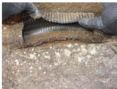
写真3 管内の状況 (③: 洗浄後)
