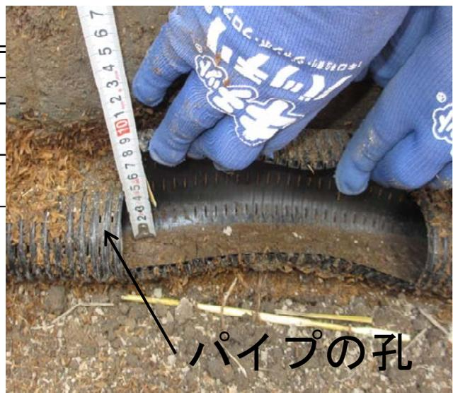
写真 土砂堆積状況
