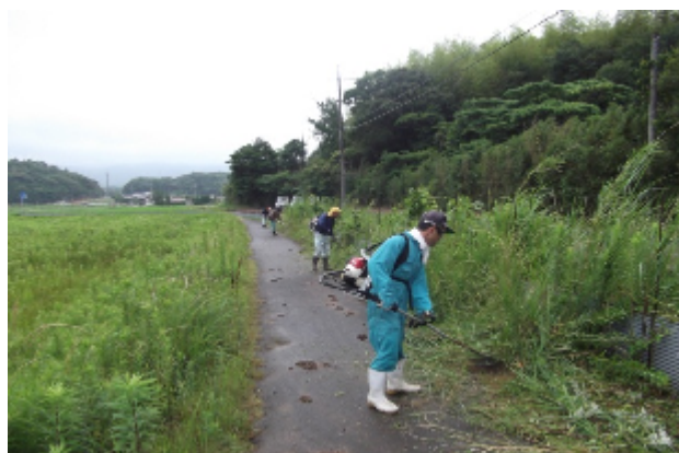
【道路等の管理状況】
