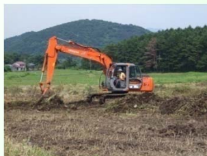
再生作業実施中
