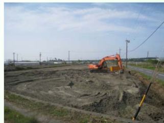
再生作業実施中
