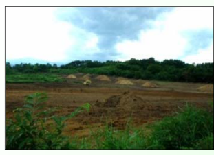
再生作業実施中
