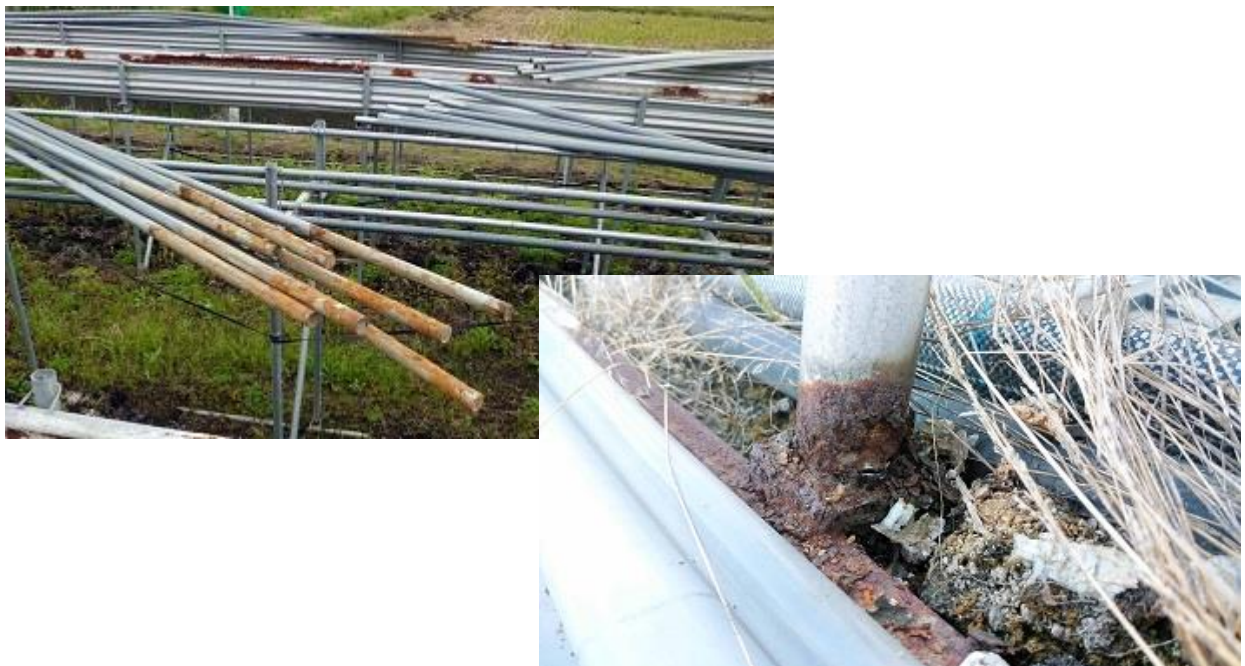
アーチパイプ等が錆びたハウス
