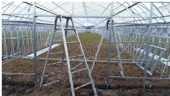
パイプハウス建設
