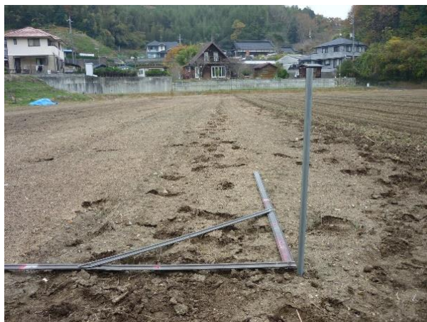
縄張り前の杭打ち作業
