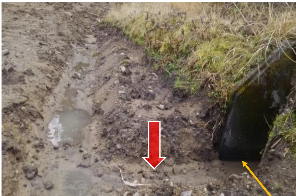
排水溝との連結
