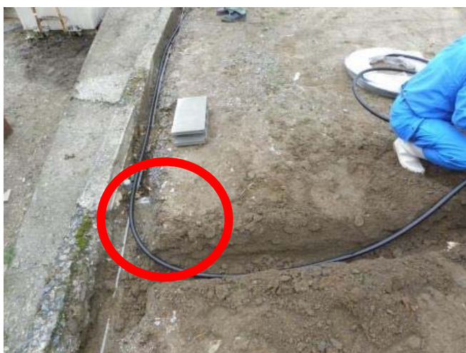
図11 ポリエチレン製パイプでの配管例 曲げやすいため、方向を変える際にも道具が不要。
