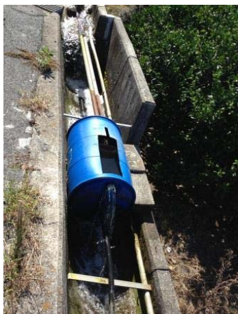
図7 河川から取水している事例
