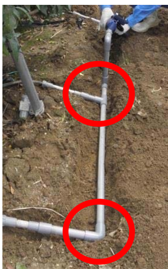
図9 塩ビ製パイプでの配管例 塩ビパイプは曲げにくいいため、 チーズやエルボで方向を変える。
