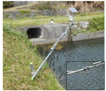
図3 遠隔監視システム（超音波式）
