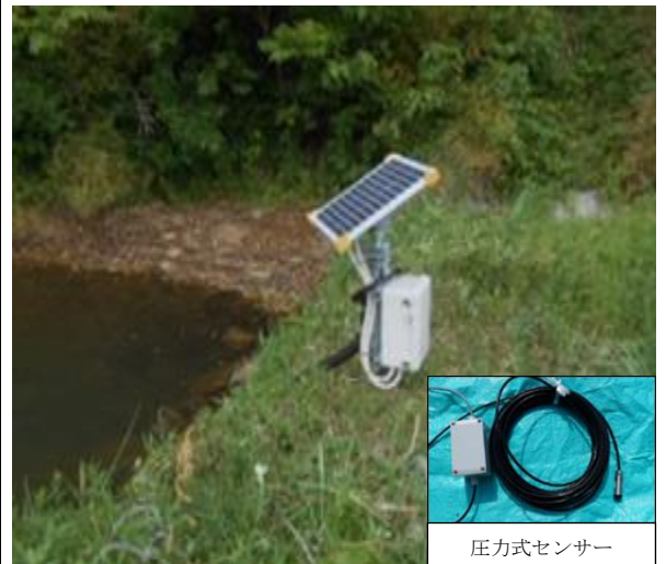
図2 遠隔監視システム設置状況(圧力式)
